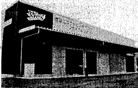
施設は新規で設置している
